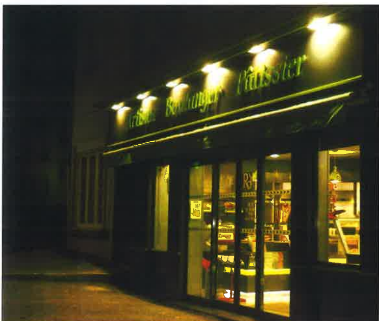
Éclairage intégré dans le bandeau
